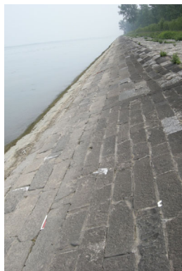
洪澤古堰 玄武岩條石砌築 (2008-6-12)
