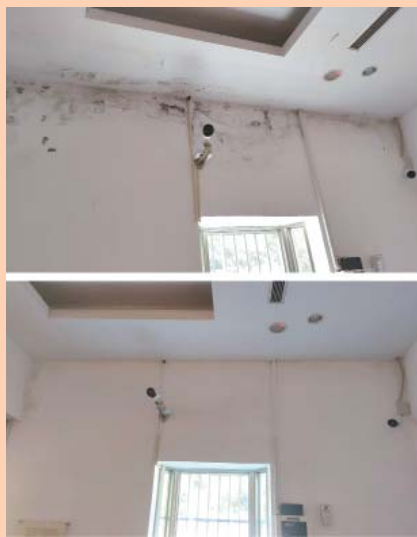
剝蝕牆面修飾之二
