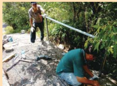
護欄加裝與設置
